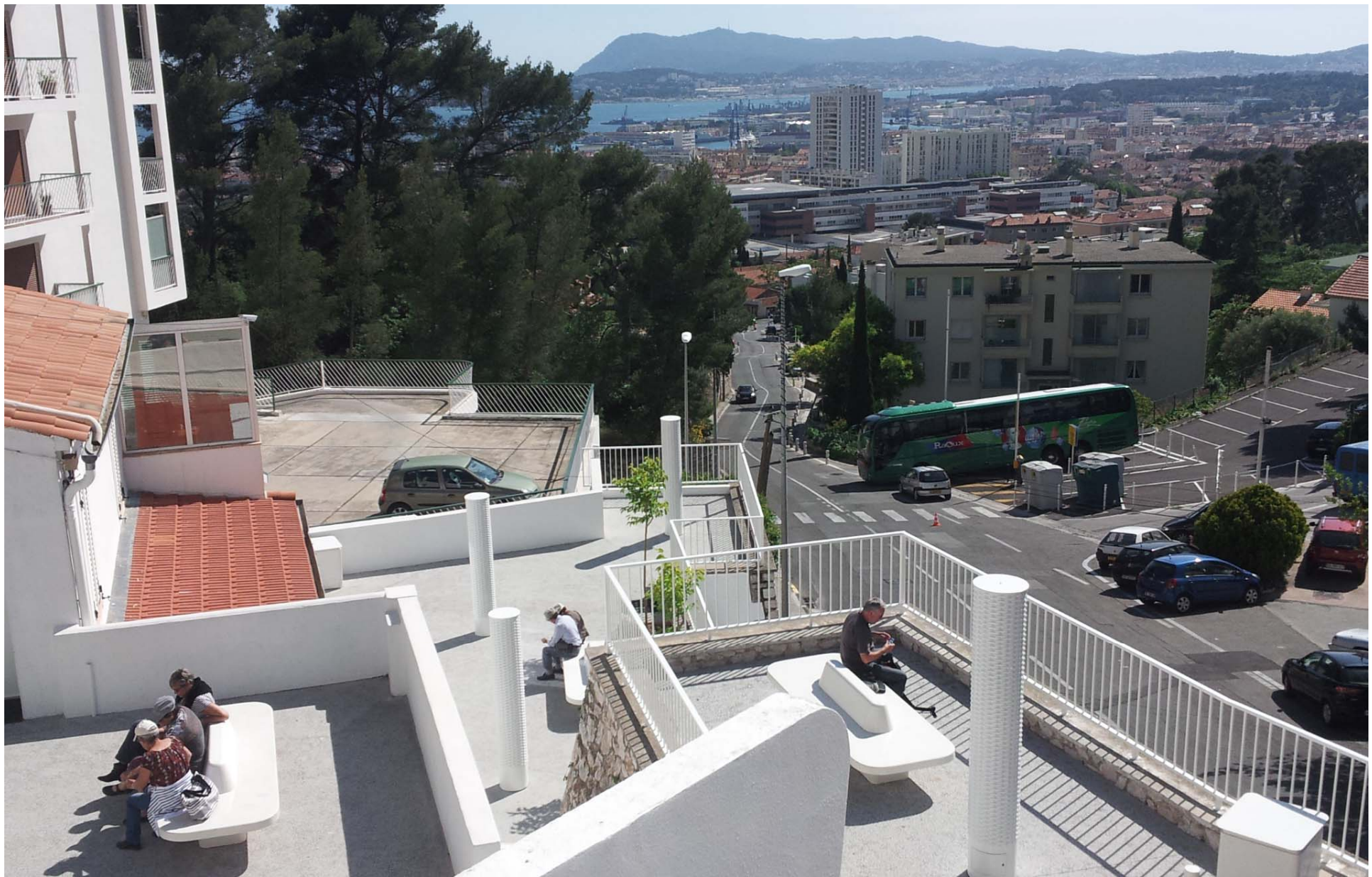
Rénovation du Téléphérique du Faron à Toulon REDIF / TPM – 2013- 2017
